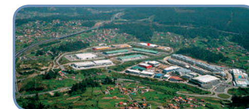
SOLO INDUSTRIAL Porto seco en Salvaterra
